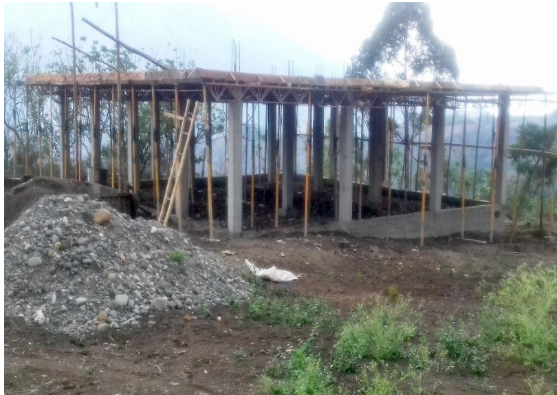
Fotografía N° 11. Construcción de la casa Comunal de la Asociación Cofradía Huacupamba
