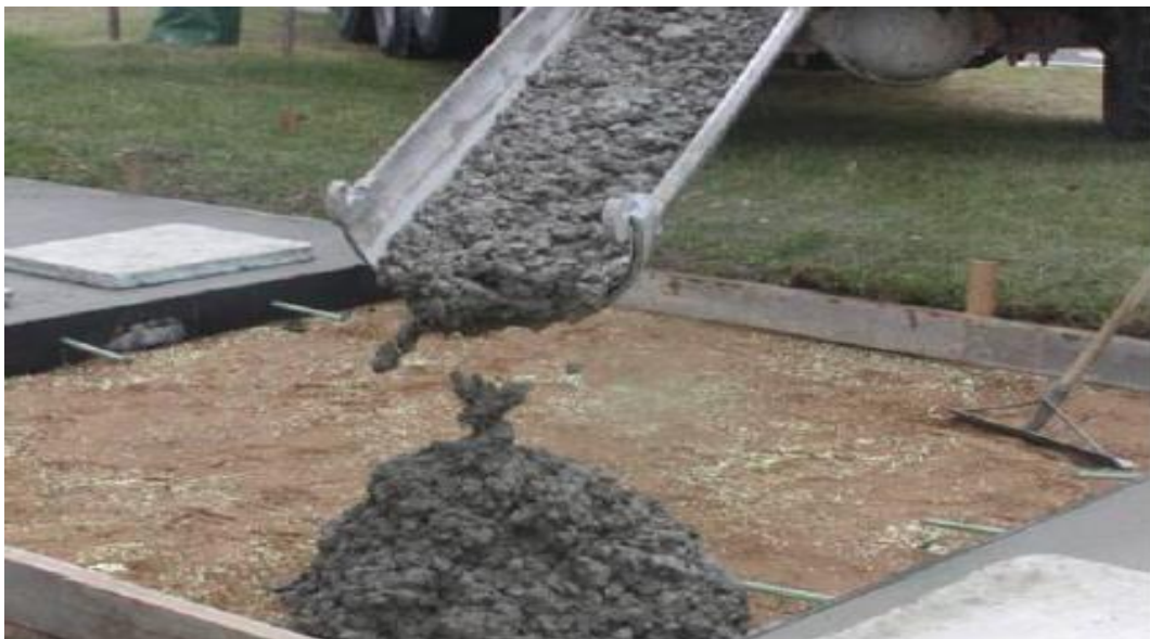
Aplicación del vidrio molido en reemplazo de agregado fino.
