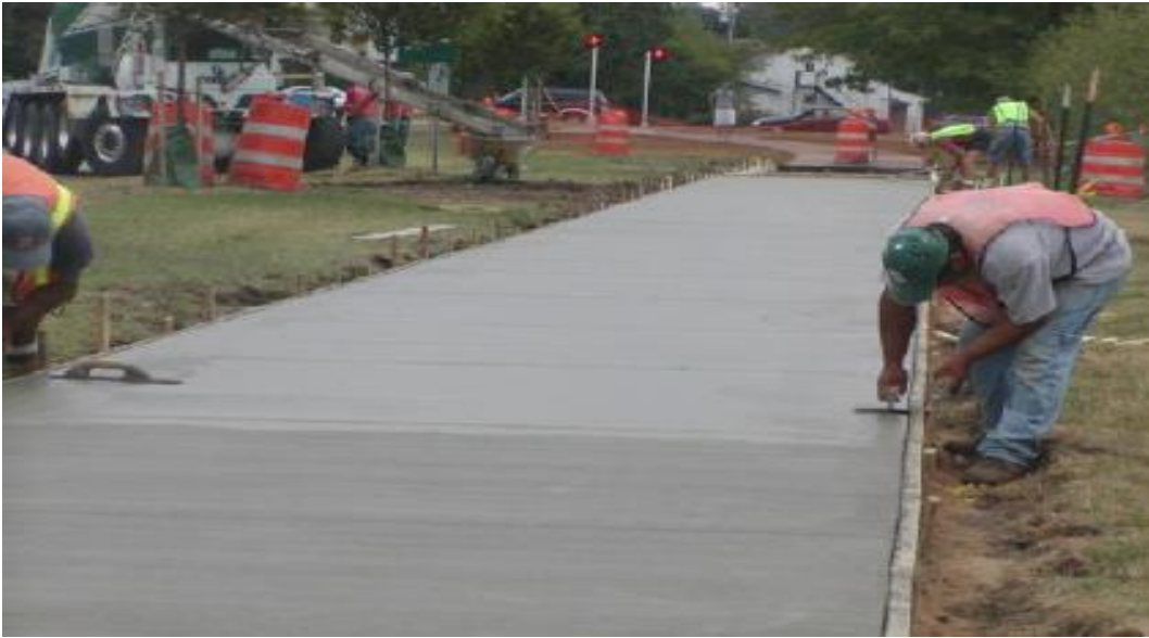
Resultados después de emplear el vidrio molido en reemplazo del agregado fino.
