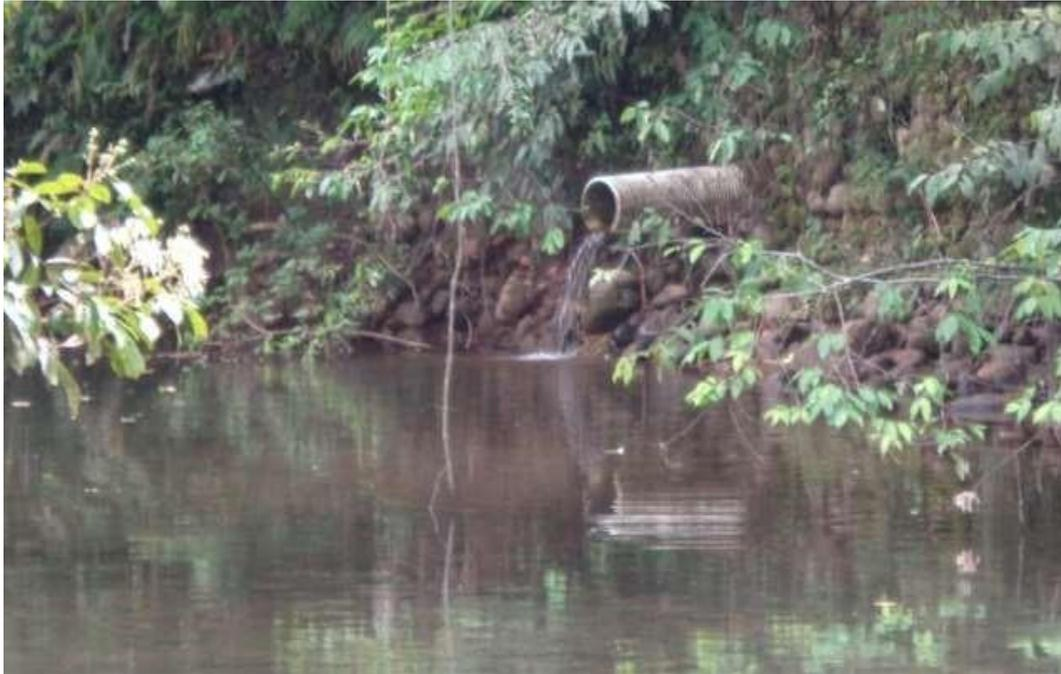
Descarga de alcantarillado al Río Puyo (Foco de contaminación)
