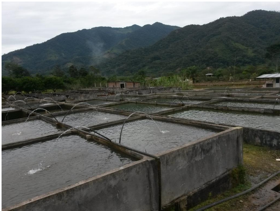
Fotografía 11. Estanques de cemento para la crianza, comercialización y venta de Tilapia.
