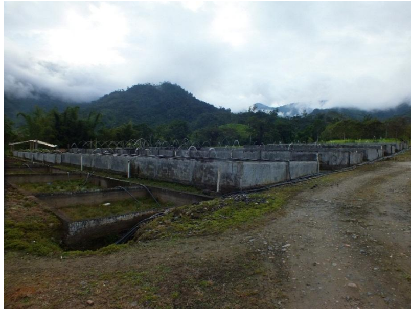
Fotografía 12. Estanques de cemento para la crianza, comercialización y venta de Tilapia.
