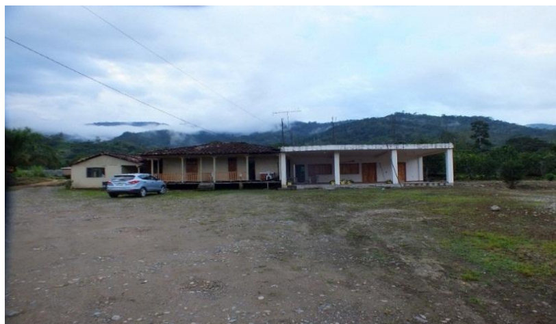
Fotografía 13. Viviendas en la finca
