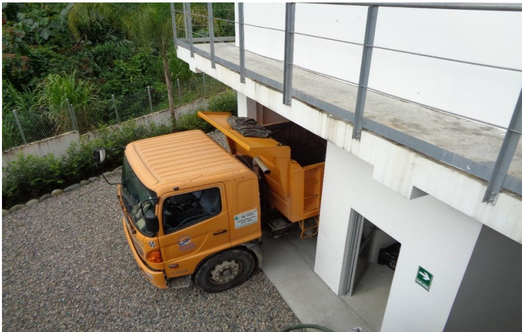
Descarga de lodos de la Planta de Tratamiento
