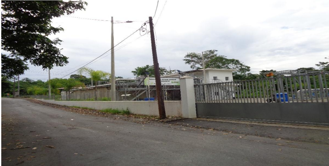
Planta de Tratamiento de Aguas Residuales -Palandacocha - Tena
