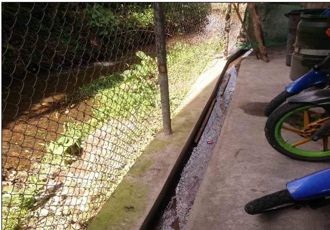
Instalaciones de la lubricadora Lubrioro
