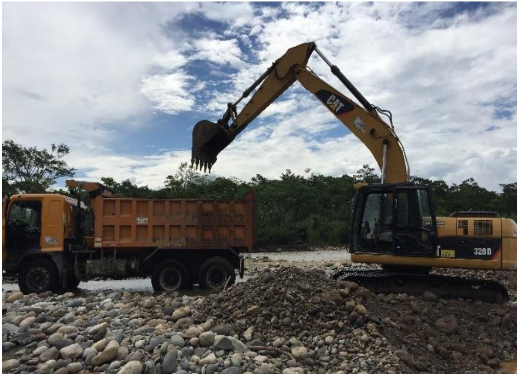
Extracción de material pétreo.
