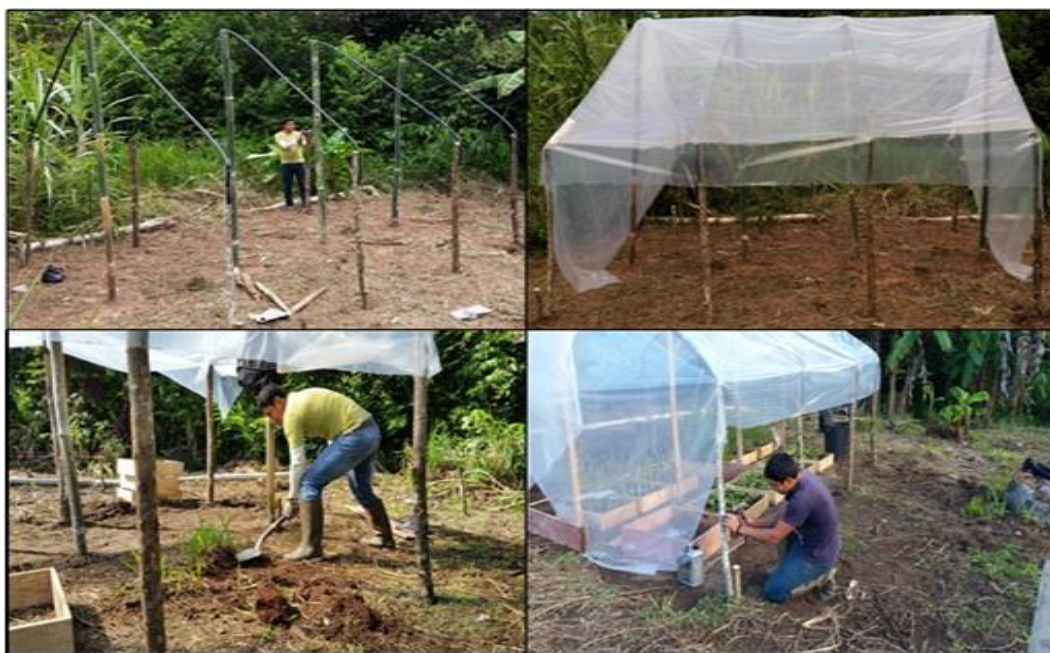
Fotografía 7. Construcción del invernadero donde se realizará el desarrollo del tratamiento de Fitorremediación.
