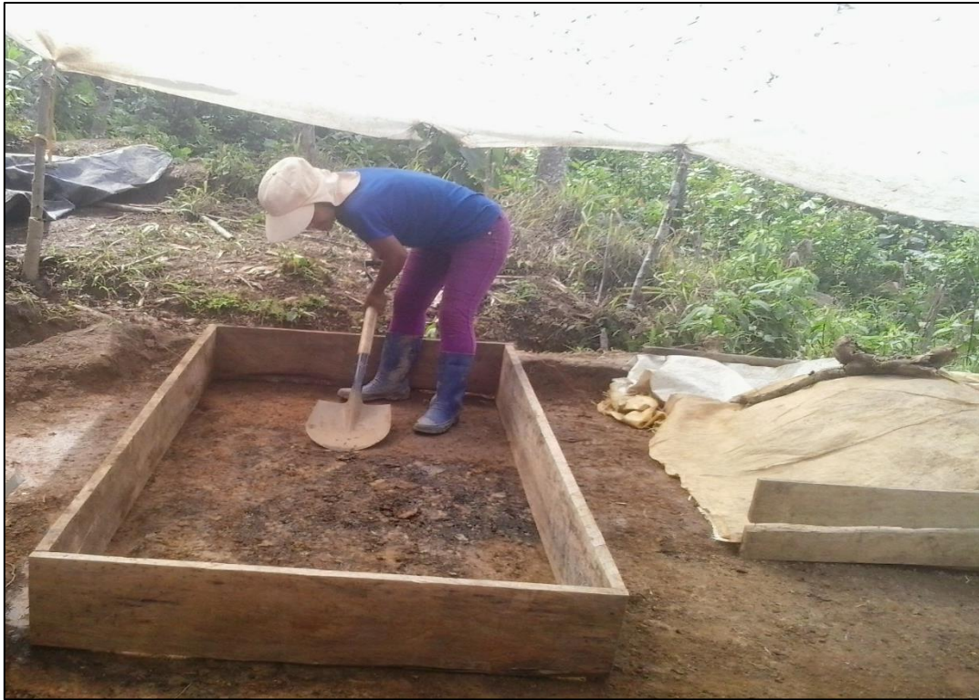
Fotografía 12. Preparación de la sub base
