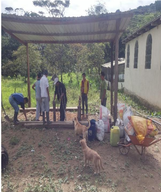
Fotografía 2 Paso 1. Adecuación del lugar
