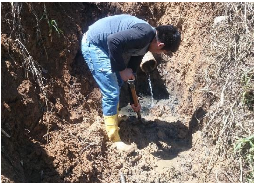
Fotografía 7. Limpieza del lugar de descarga del agua residual.
