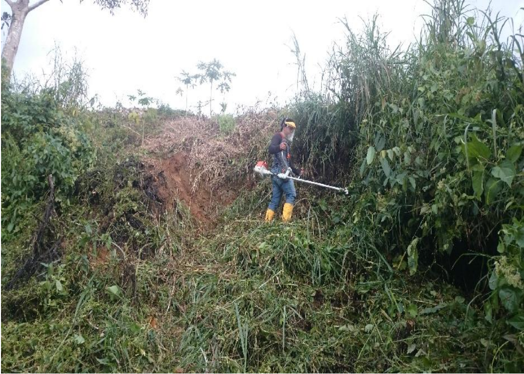
Fotografía: Limpieza del lugar de la descarga de agua residual.
