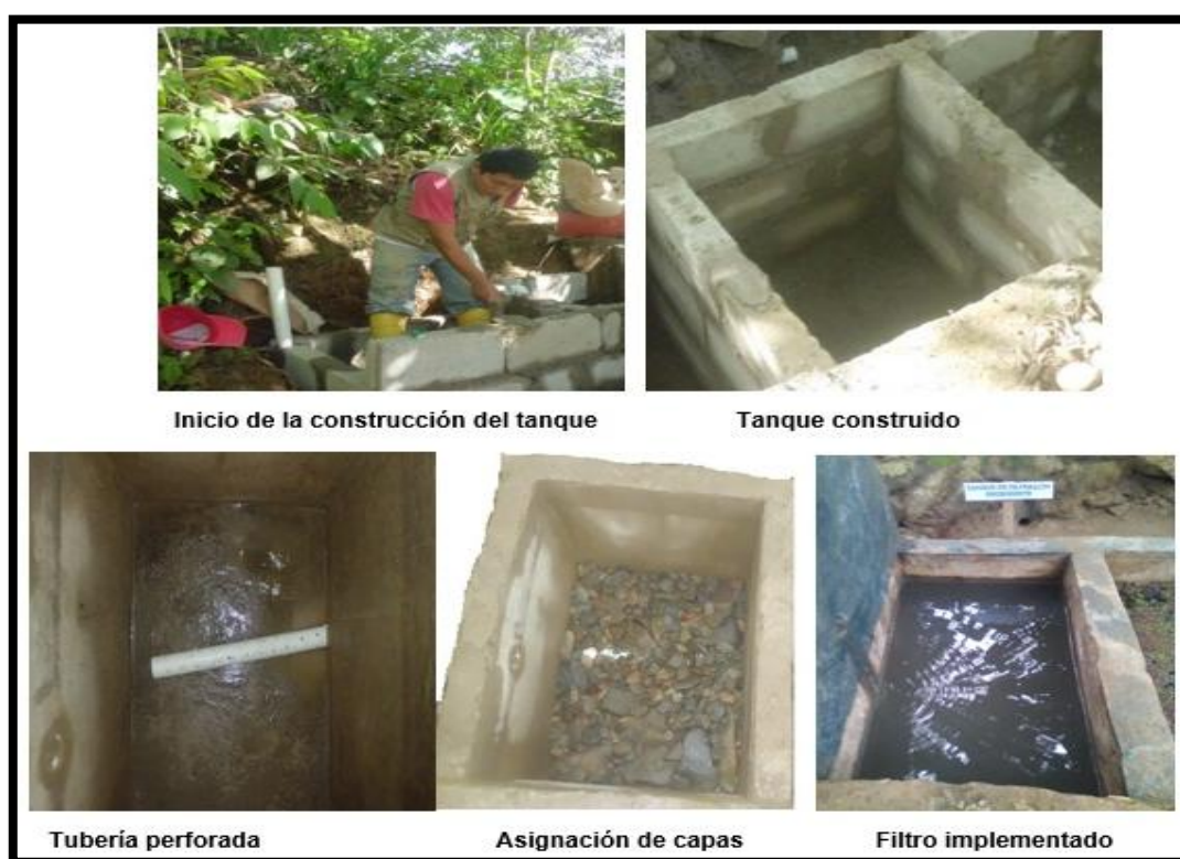
Fotografía 14. Construcción y terminación del filtro descendente.
