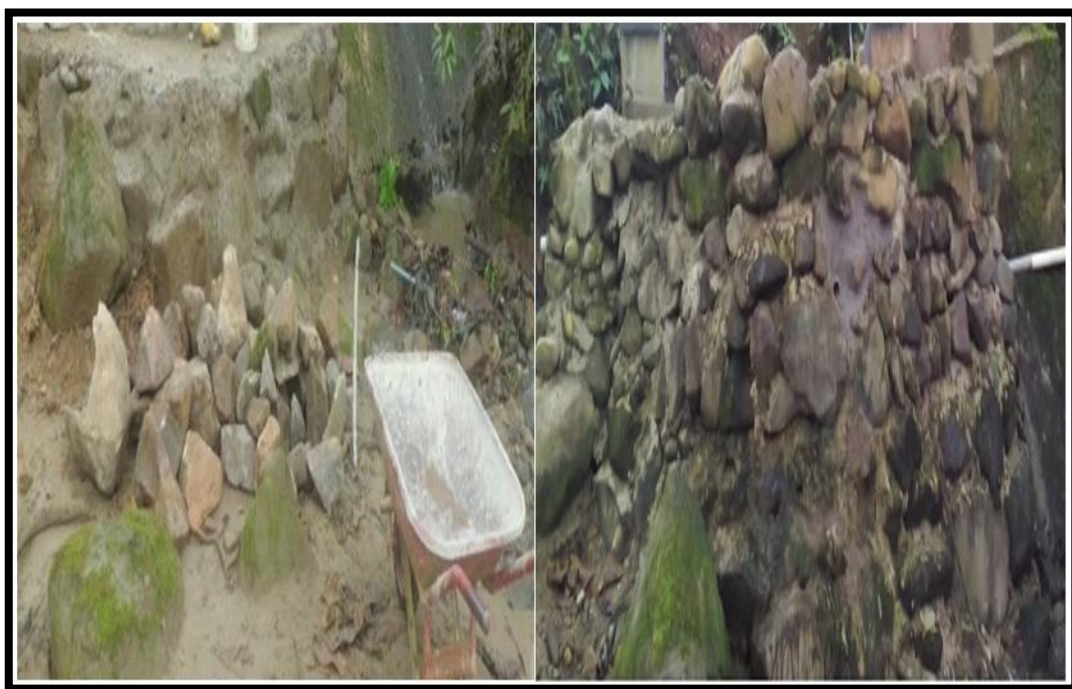
Fotografía 9. Construcción y acabado del muro de piedra.
