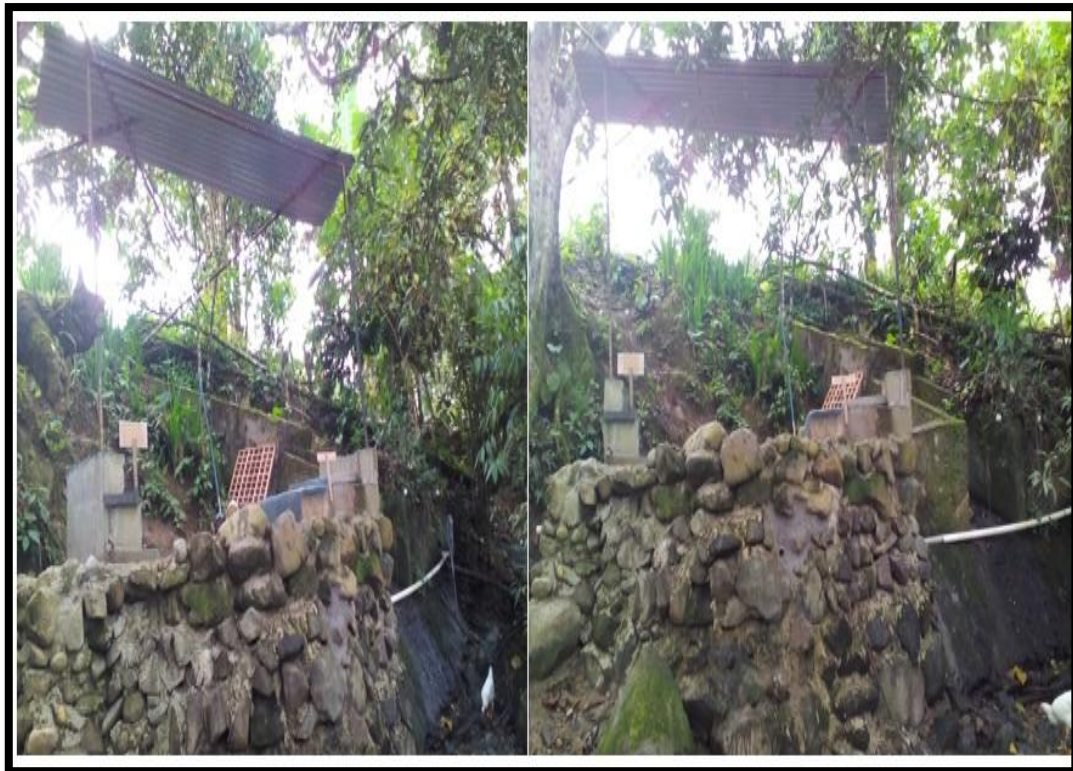
Fotografía 12. Terminación de la cubierta.
