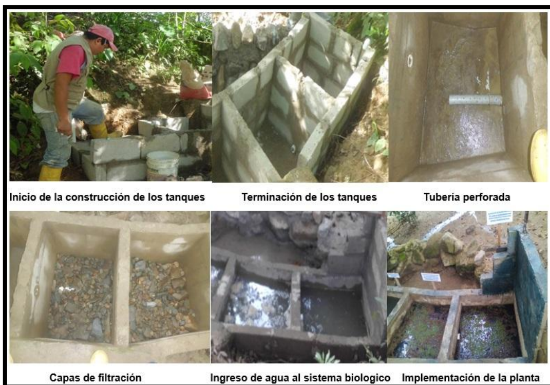
Fotografía 15. Construcción y terminación del sistema biológico.
