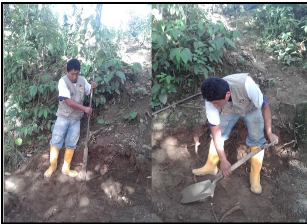
Fotografía 10. Adecuación del terreno.
