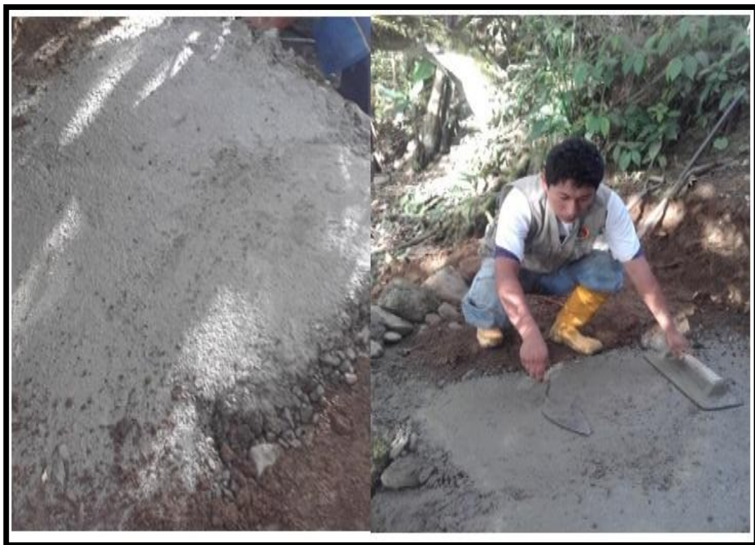
Fotografía 11. Replantillo y pulido del piso
