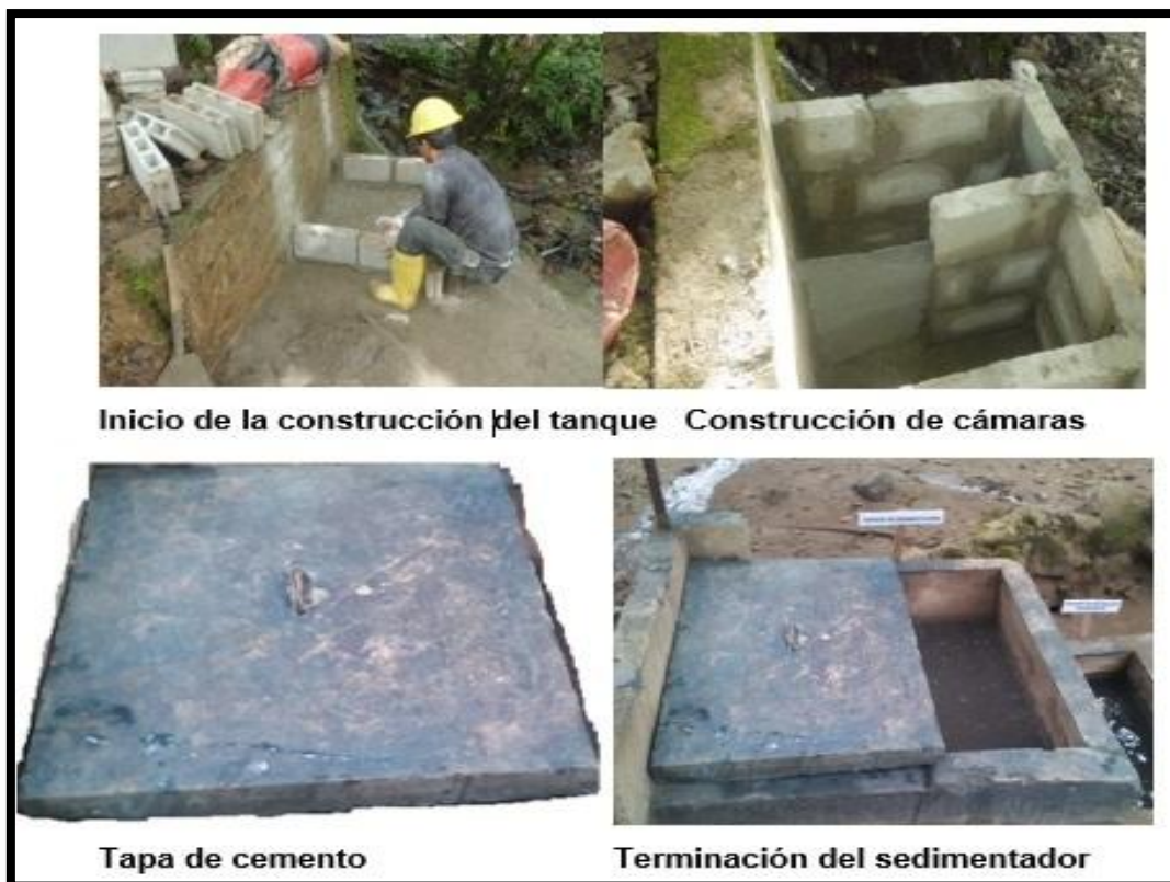
Fotografía 13. Construcción y terminación del tanque sedimentador
