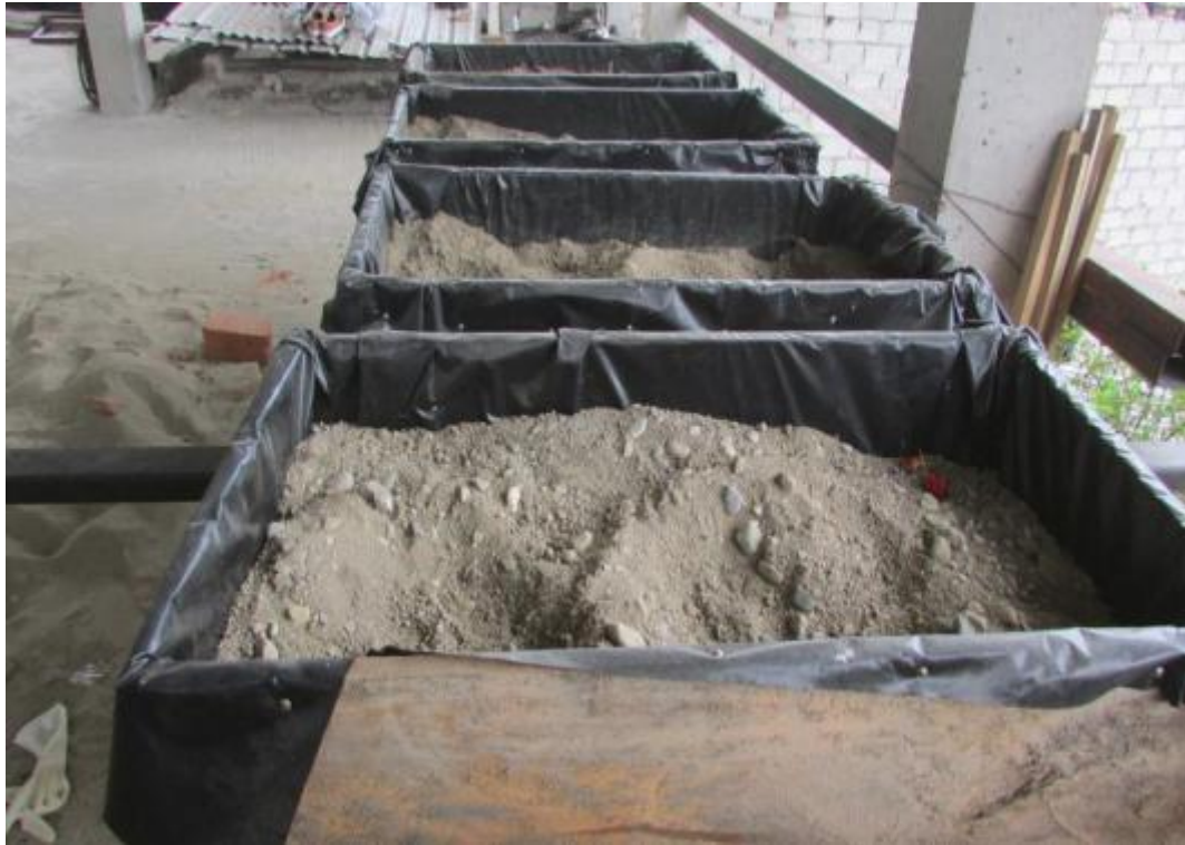
Fotografía 8. Colocación del material en las platabandas
