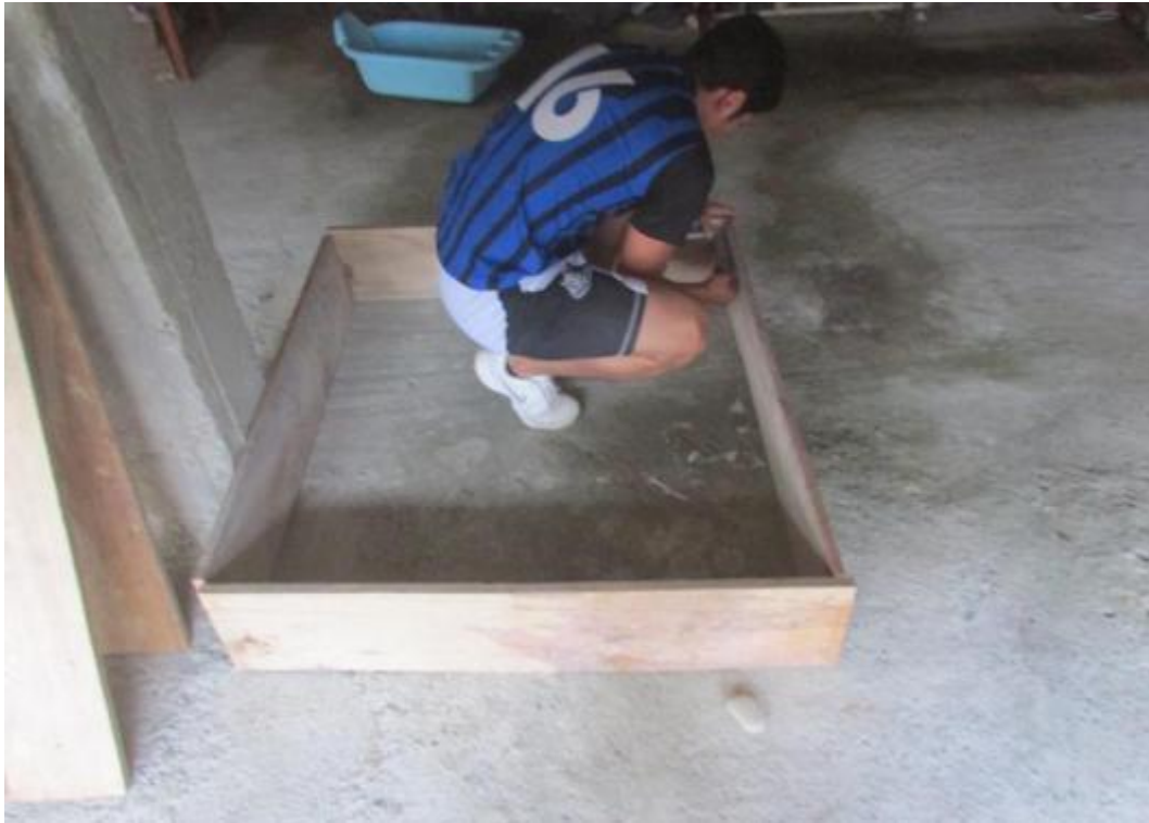
Fotografía 7. Construcción de la Platabanda
