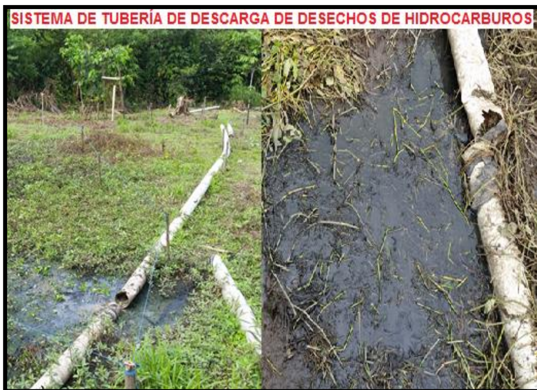
Fotografía 26.- Collage, sistema de descarga de desechos de hidrocarburos.
