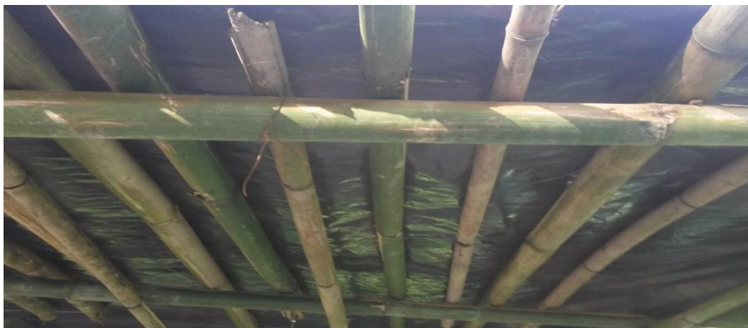
Fotografía 3. Cubierta de las piscinas experimentales
