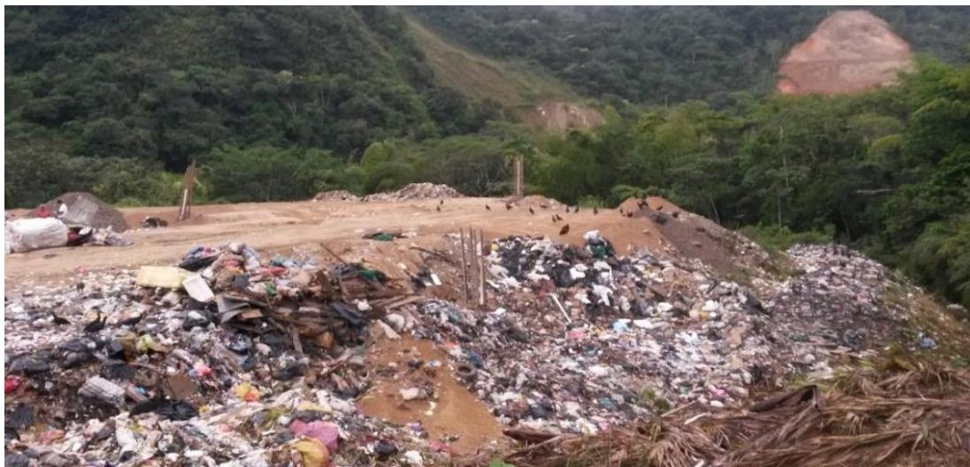
Fotografía 12. Vista del relleno sanitario, sus chimeneas de aireación y eliminación de gases.
