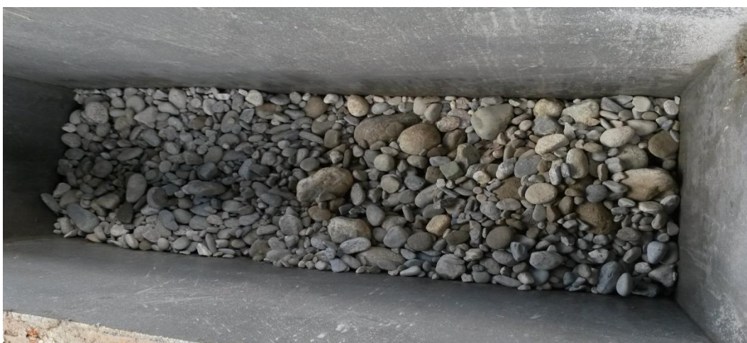
Fotografía 5. Colocación del material mediano grava.
