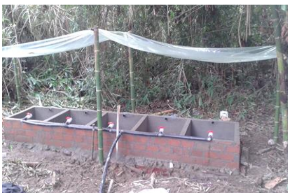
Fotografía 4. Colocación del techo en las piscinas experimentales.
