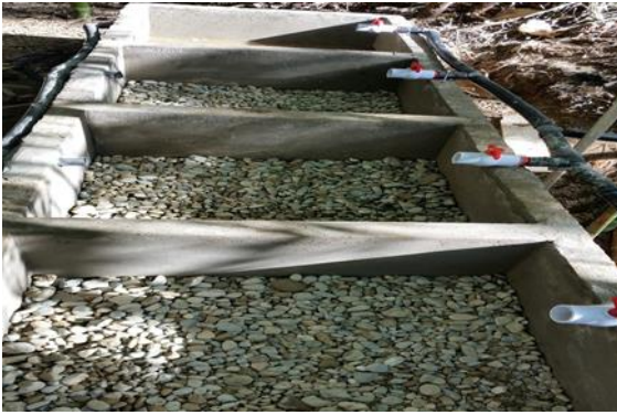
Fotografía 6. Colocación de grava en las piscinas experimentales.
