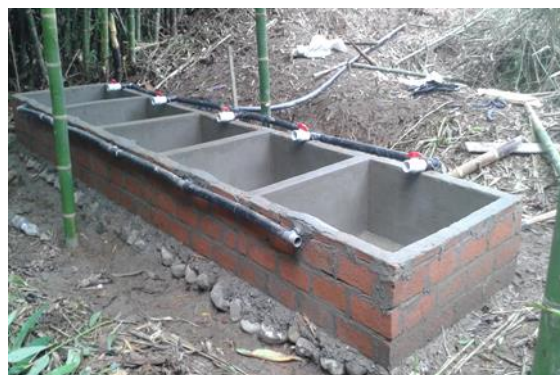
Fotografía 3. Instalación de tuberías en las piscinas experimentales.
