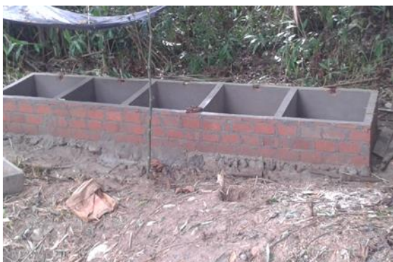
Fotografía 2. Construcción de las piscinas experimentales.
