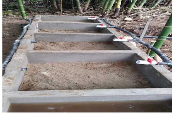
Fotografía 7. Colocación de tierra en las piscinas experimentales.
