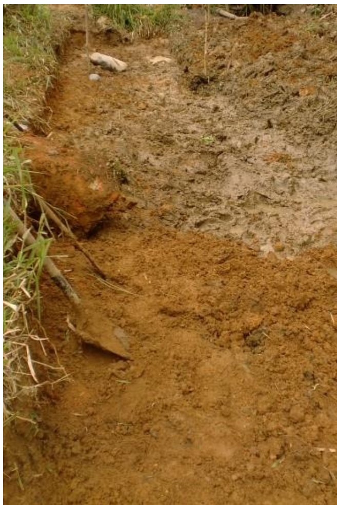
Fotografía 10. Excavación y nivelación del terreno
