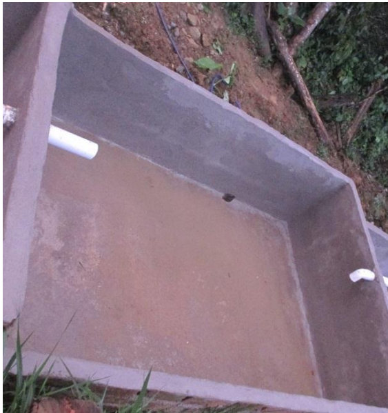
Fotografía 14. Revestido del humedal artificial-superficial
