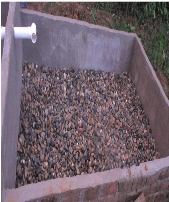
Fotografía 16. Medio poroso granular de grava, gravilla, y arena
