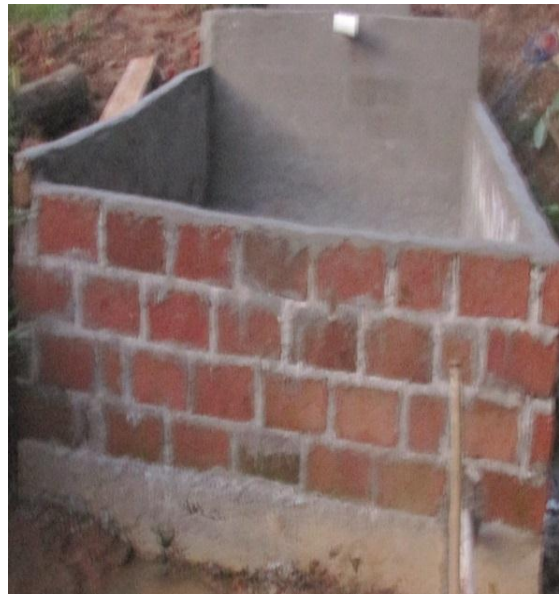
Fotografía 15. Revestido del humedal de flujo subsuperficial horizontal
