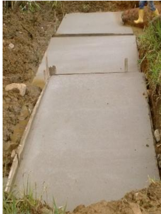
Fotografía 11. Construcción de la losa de concreto de 0,15 m de espesor para impermeabilizar la superficie del suelo.
