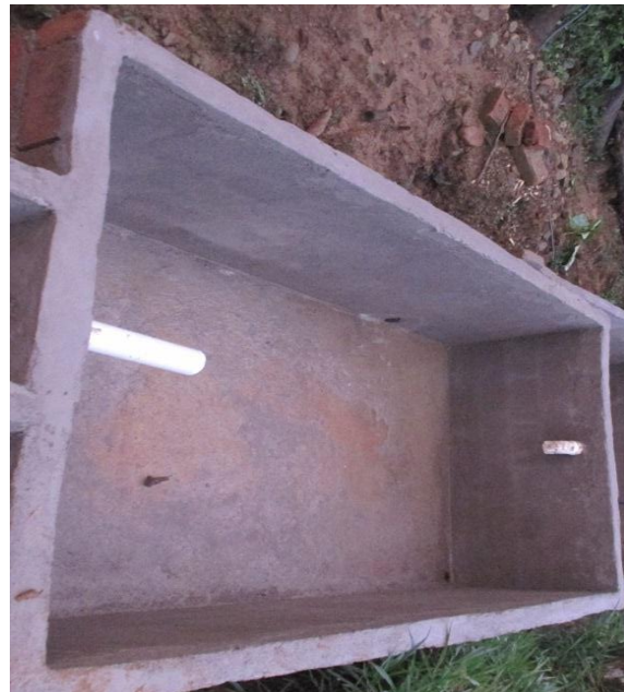
Fotografía 13. Revestido del tanque de sedimentación
