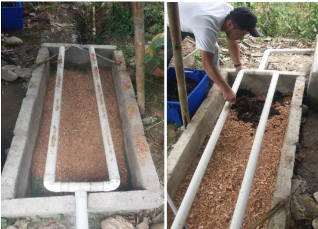
Fotografía 8. Colocación de aserrín, materia orgánica, lombrices y sistemas de entrada y salida del agua residual en el tanque de biofiltración.
