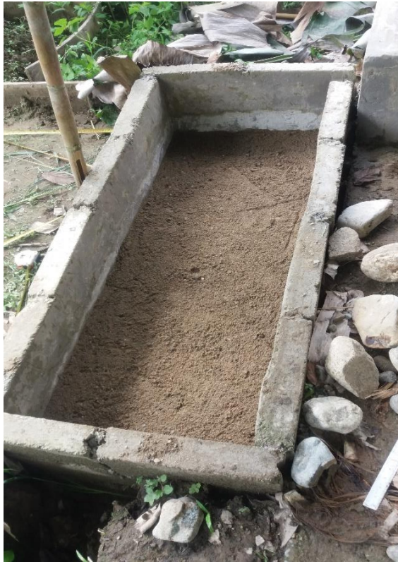
Fotografía 7. Colocación de una capa de arena fina en el tanque de biofiltración.
