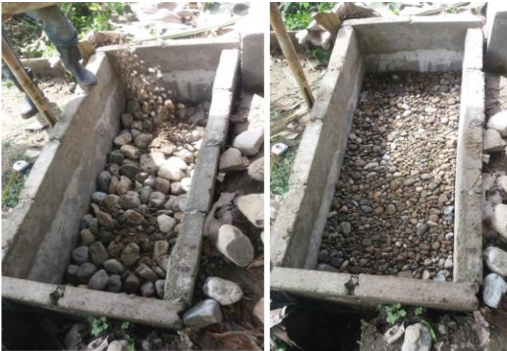
Fotografía 6. Colocación de una capa de grava 3/4 en el tanque de biofiltración.
