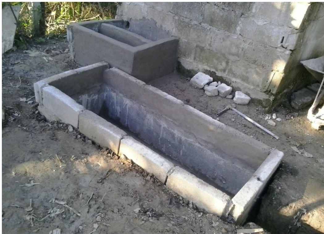
Fotografía 4. Armado del tanque de biofiltración con paredes de bloque.
