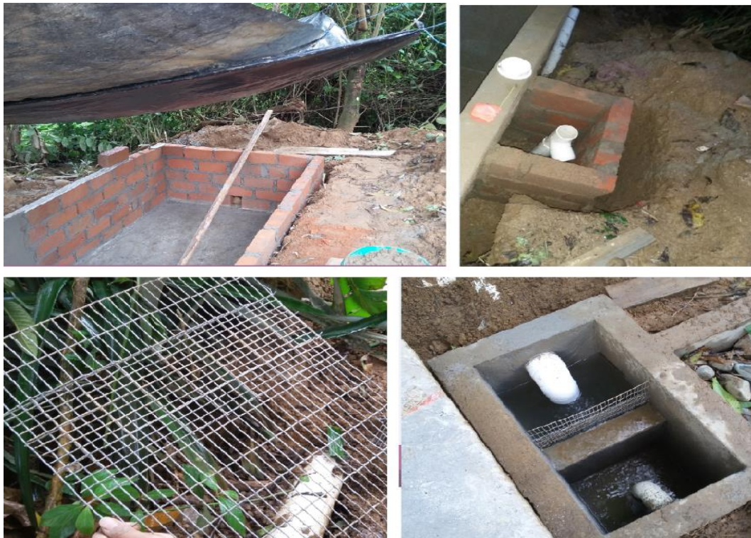
Foto 6: Construcción de paredes de las distintas cajas.
