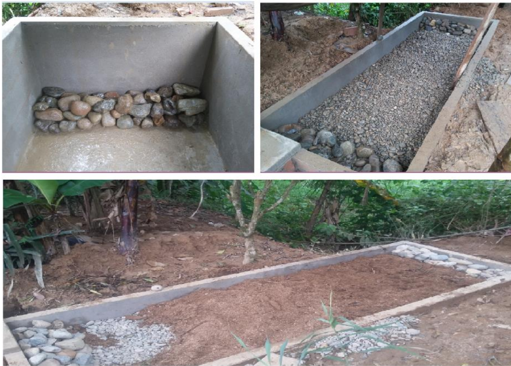
Foto 8: Colocación de las capas filtrantes.
