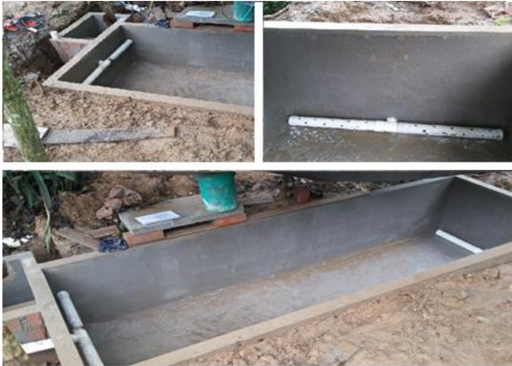
Foto 7: Colocación del sistema de entrada y salida del agua residual.
