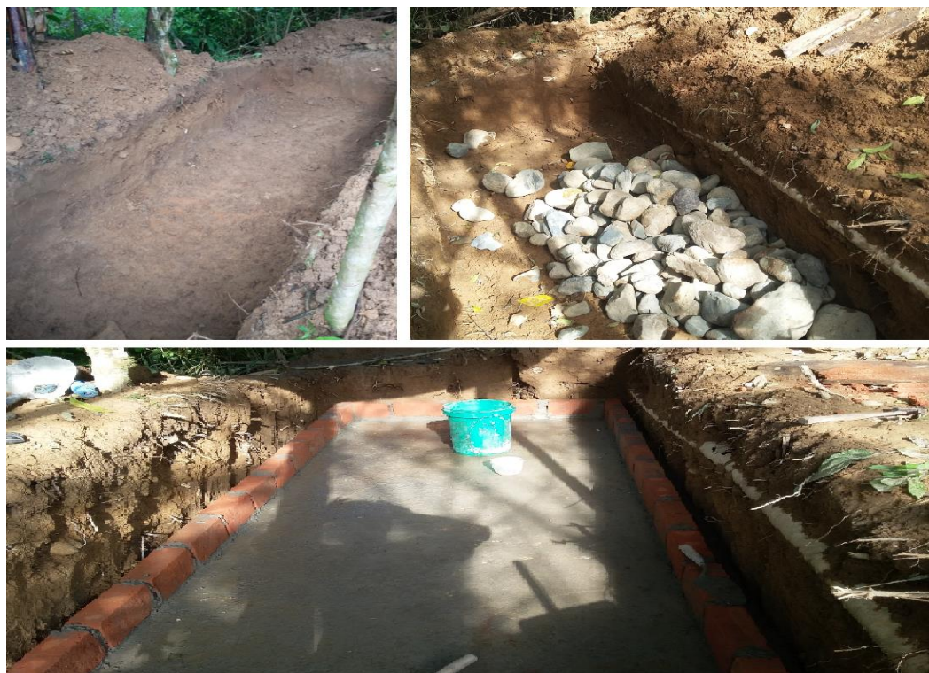
Foto 5: Impermeabilización del área.
