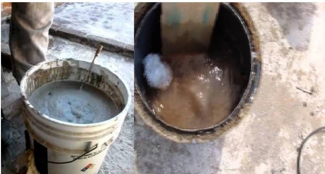
Fotografía .- Incorporación del impermeabilizante en la mezcla.
