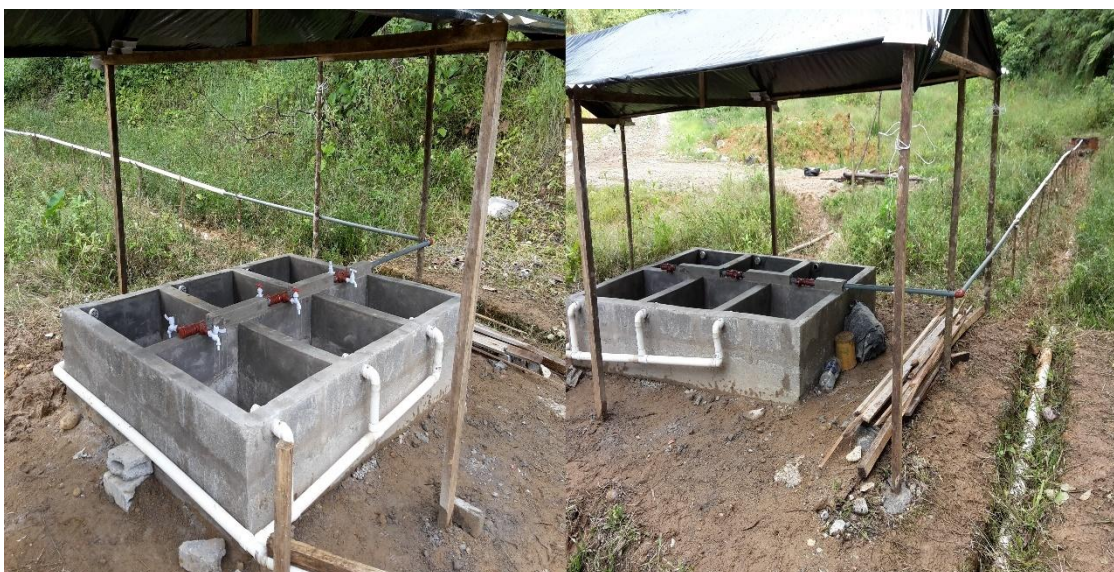
Fotografía .- Instalación del sistema de tuberías.
