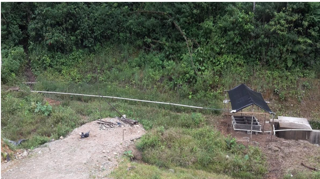
Fotografía .- Colocación de la cubierta.
