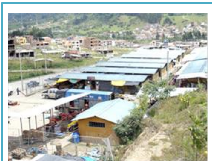
Figura 5. Infraestructura Inicial del Mercado del Pequeño Productor
