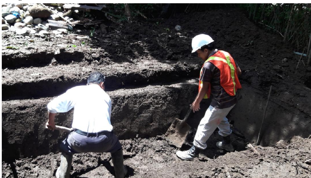
Excavación del terreno
