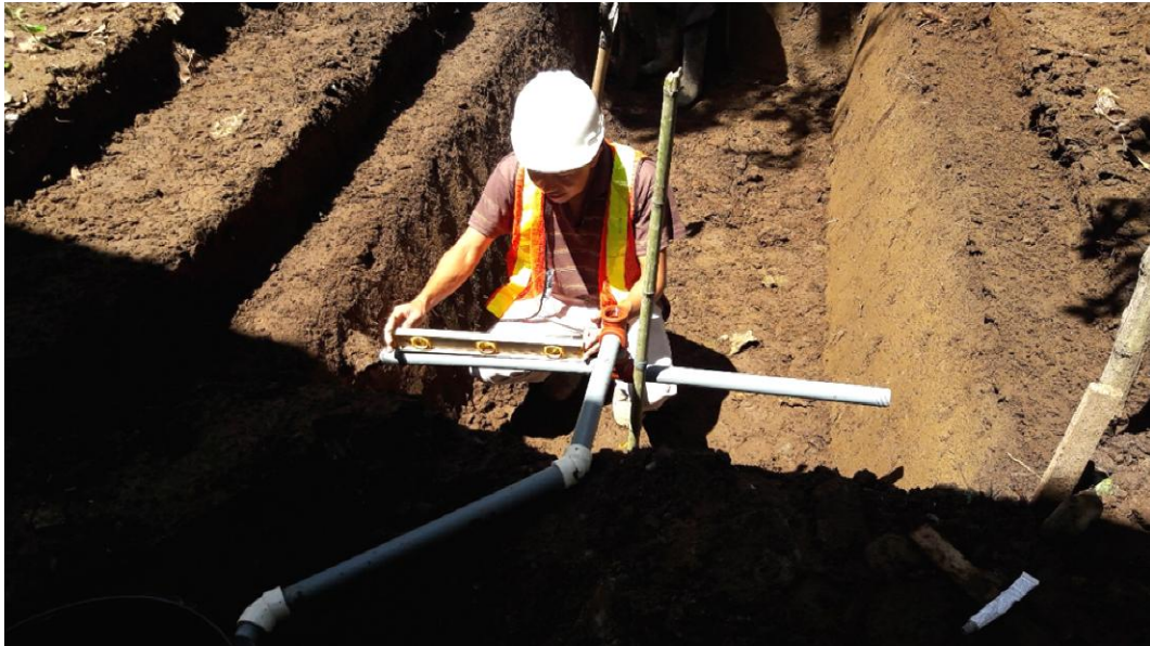
Colocación de tubos (salida de aguas grises del tratamiento primario)
