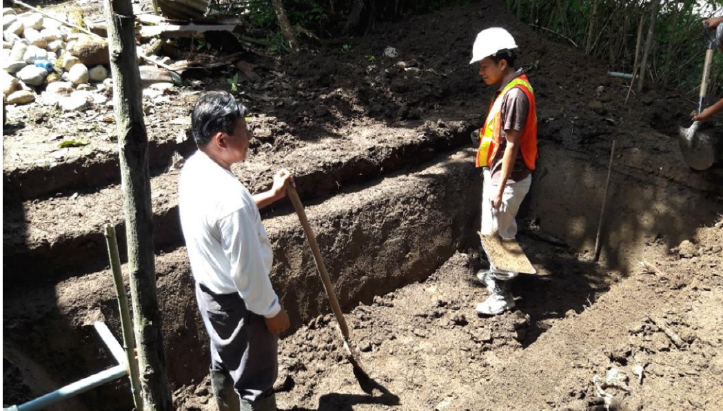
Excavación del terreno (Construcción)
