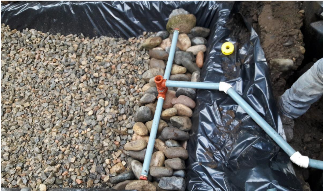
Colocación de piedra triturada
