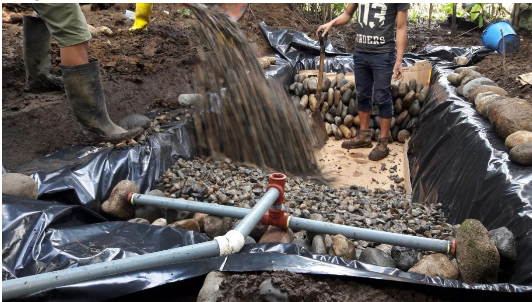
Colocación de piedra bola y piedra triturada
