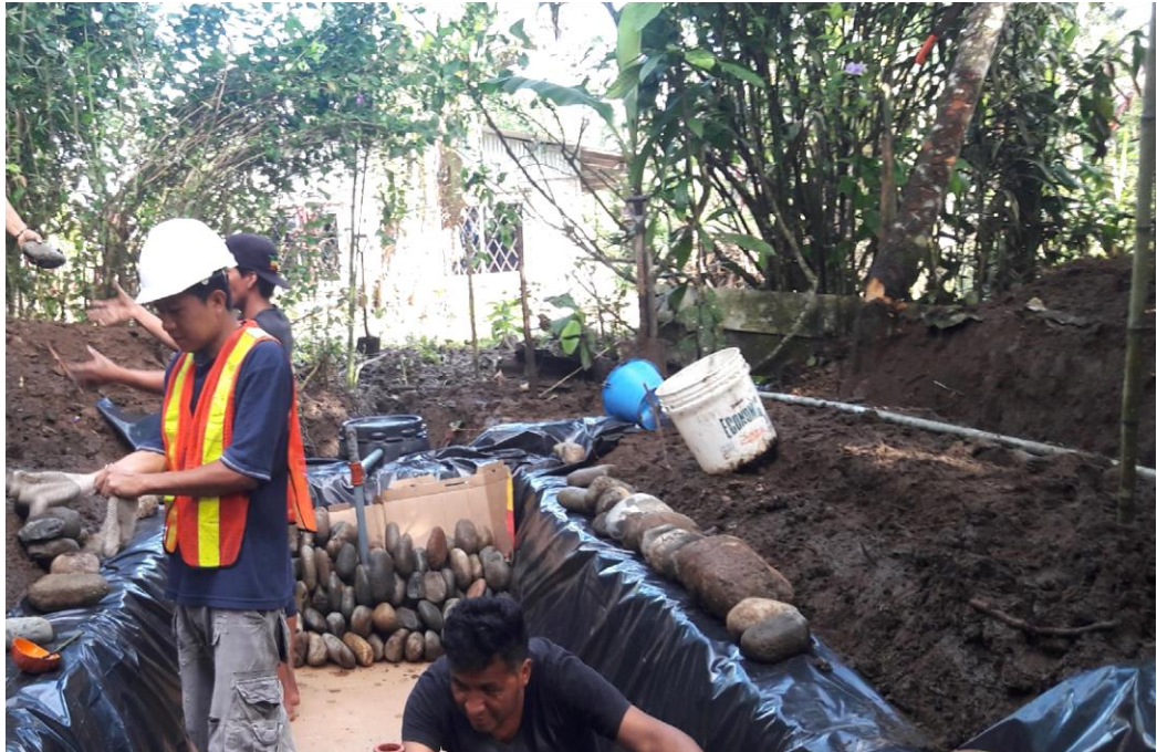
Colocación del plástico y piedra bola
