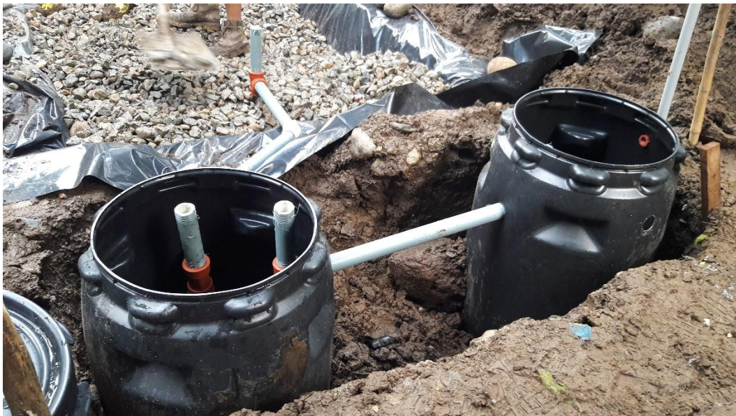
Colocación de recipientes (Tratamiento primario)
