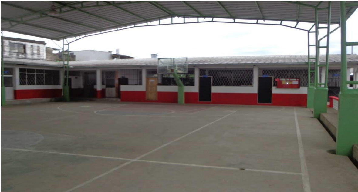
Cancha cubierta de uso múltiple
