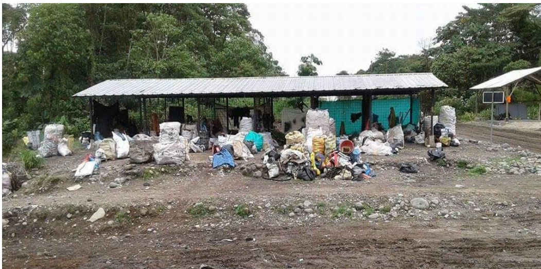
Área de separación de residuos
