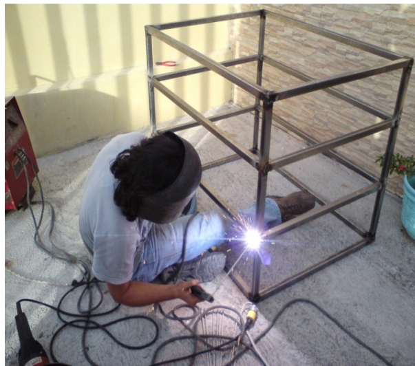
Fig. 3.3 Proceso de soldadura de los compartimentos de la estructura metálica
