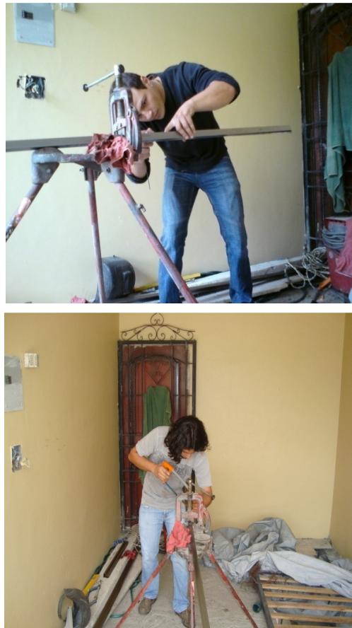
Fig. 3.1 Proceso de medición y corte de la estructura metálica
