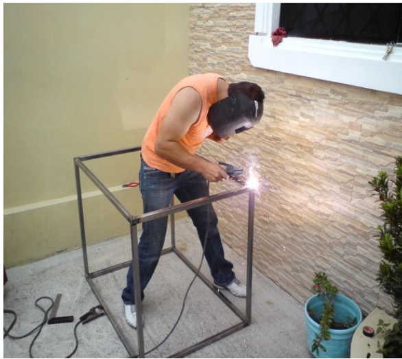
Fig. 3.2 Proceso de soldadura de la estructura metálica
