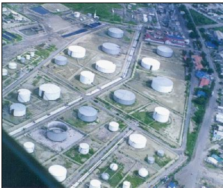
Figura 1. 3 Tanques de Almacenamiento de Petróleo en Complejo Industrial Shushufindi. 3
