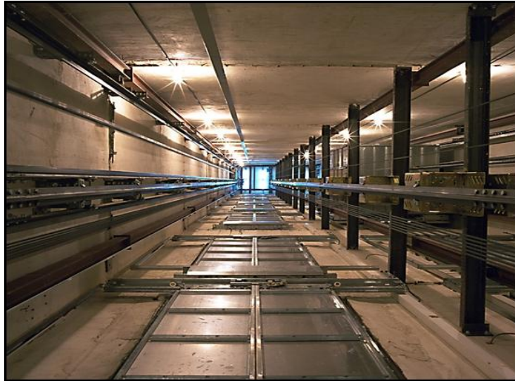
Figura 3.1 (Hueco del ascensor)
