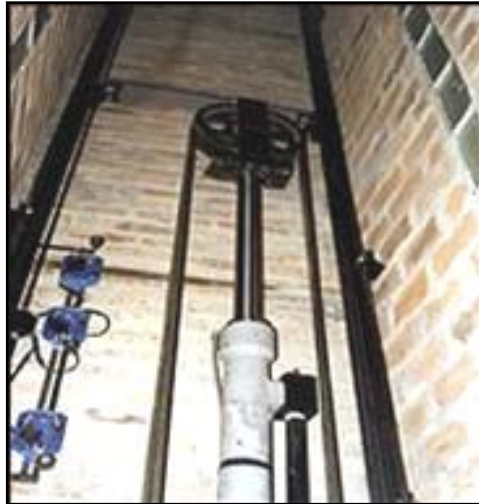
Figura 3.3 (pistón del ascensor)
