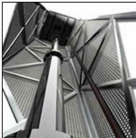
Figura 3.2 (Ascensor Hidráulico)
