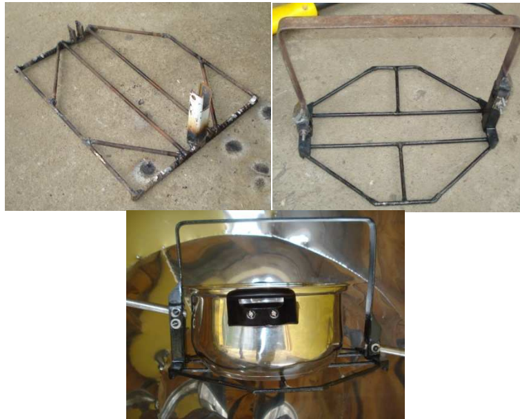
Figura 4.29: Construcción y montaje de la parrilla en la cocina parabólica
