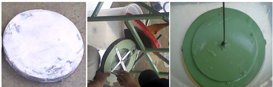
Figura 4.22: Construcción y montaje de flotadores
