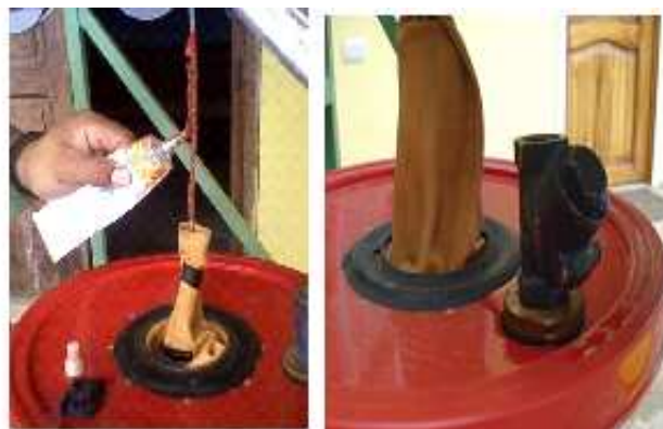
Figura 4.24: Montaje del tanque de descarga (bolsa de caucho, válvula check)
