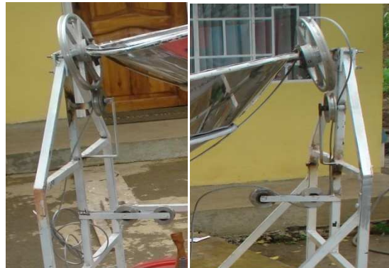
Figura 4.21: Colocación de poleas y cable de acero
