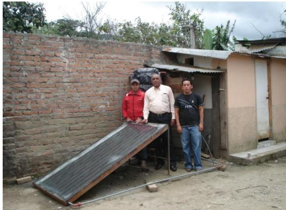
**Colector solar para el calentamiento del agua**
