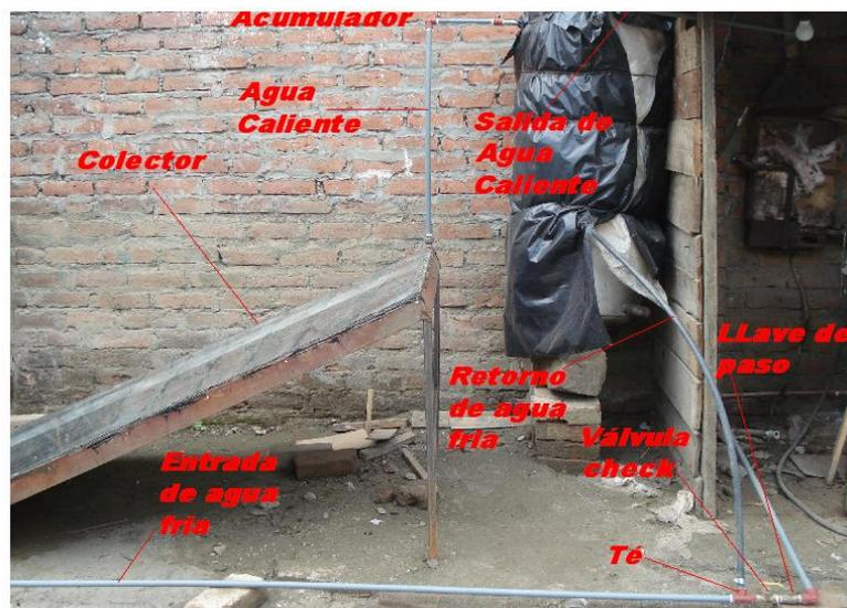
**Fig. 5.67. Equipo solar instalado para agua caliente**
