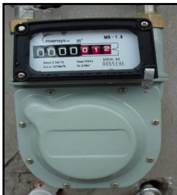
Fig 11. Contador volumétrico.
