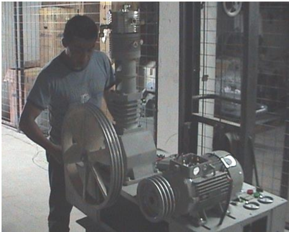
Figura 142. Compresor en proceso de montaje.
