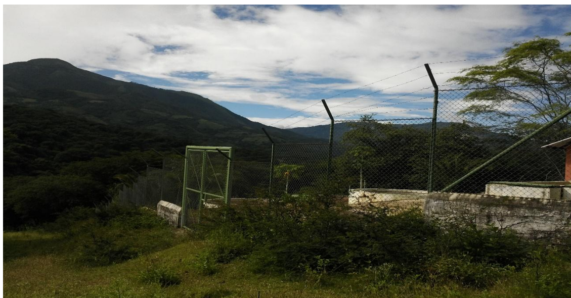
Figura 8. Infraestructura del Reservorio Municipal del CBFTZ
