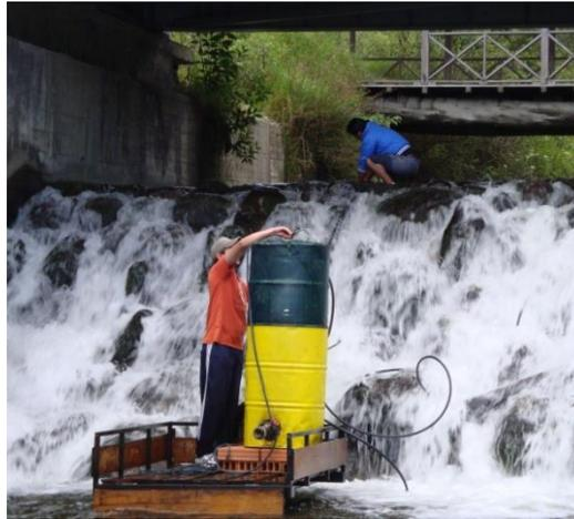
Fig. 11 Instalación del tanque de alimentación (río Zamora)
