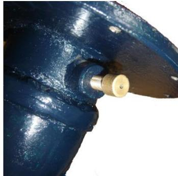
Fig. 1.2 Válvula de purga de aire
