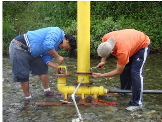
Fig. 12 Instalación del ariete de aguas bravas en el río Zamora
