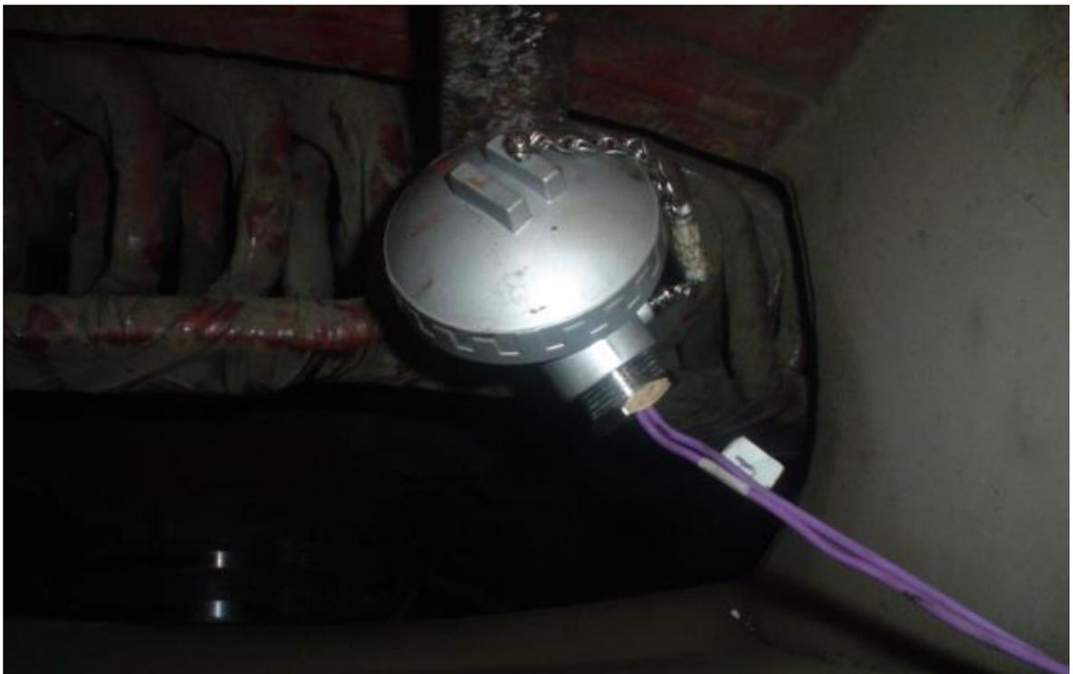
Montaje del sensor de temperatura en los arrollamientos del generador (vista superior)
