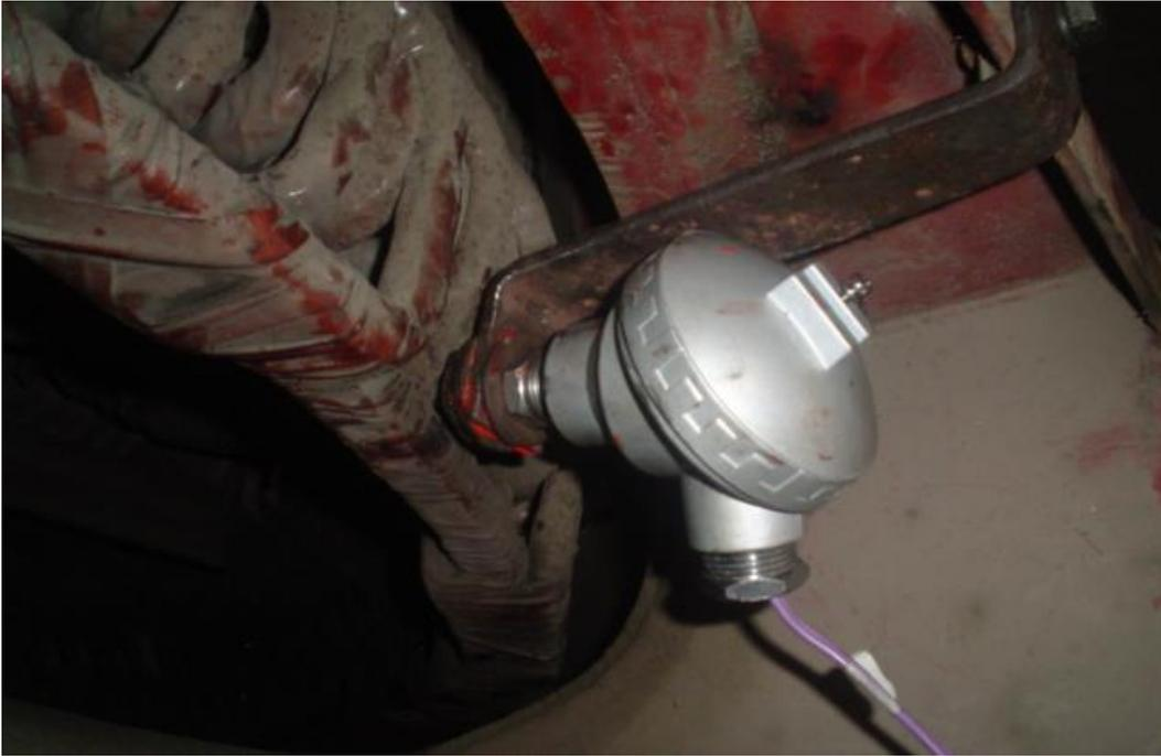
Montaje del sensor de temperatura en los arrollamientos de la máquina (vista lateral)
