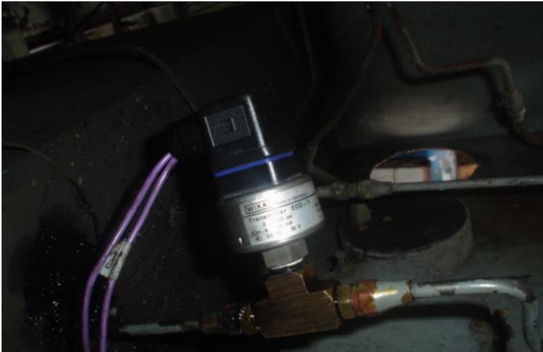
Montaje del sensor de presión en la cañería de entrada al manómetro (Puede observarse la T con los dos reductores acoplados a la cañería de cobre de 1/8").
