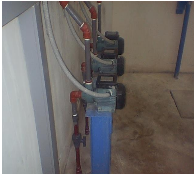
Fig.2-1 Instalación de Bombas centrífugas
