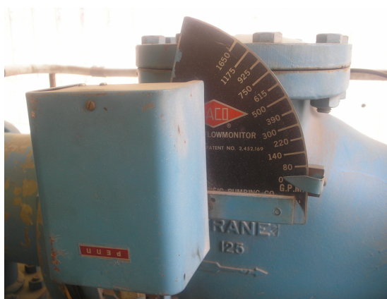
Figura 17. Medidor mecánico de caudal de agua
