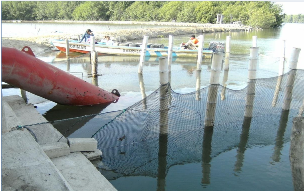
TURBINA (Para facilitar el ingreso de agua)
