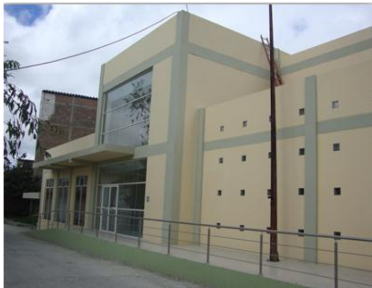
Ilustración 139. Edificio de Hemodiálisis.
