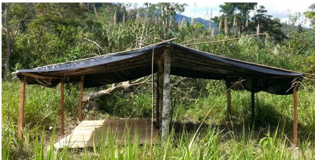
Fotografía 4: Construcción del área de elaboración de abonos.
