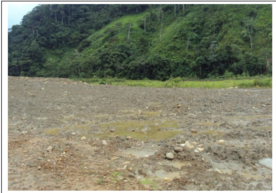
Foto 16. Subsuelo colocado nuevamente en el área donde se realizó la actividad minera aurífera.
