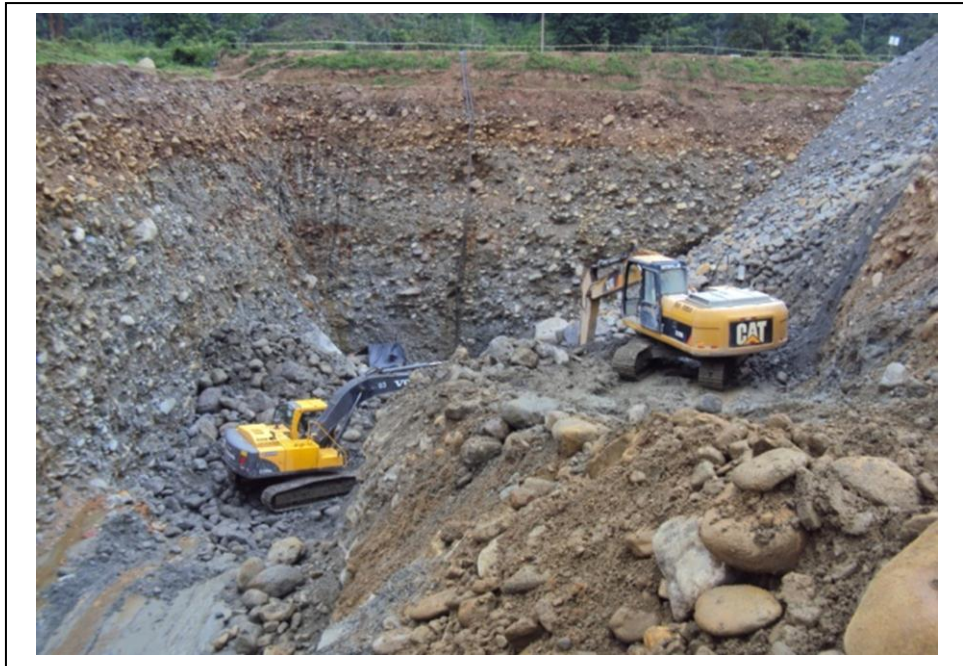
Foto 13. Excavación y extracción del subsuelo, cuya profundidad es de aproximadamente 30 metros.
