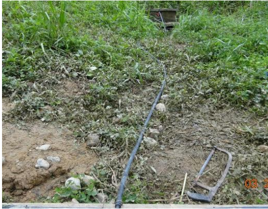
Fotografía 1. Elección del sitio a construir las piscinas
