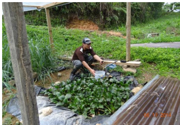
Regulación del caudal de lixiviado que ingreso hacia las piscinas
