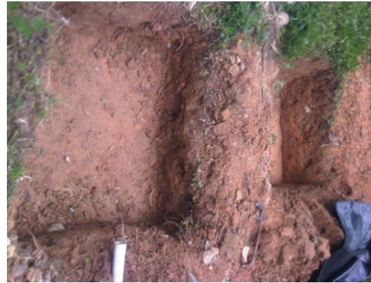
Fotografía 2. Construcción de las piscinas de experimentación
