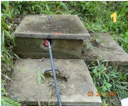
Captación de los lixiviados desde la caja de revisión
