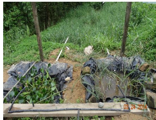
Fotografía 6. Llenado de las piscinas con el lixiviado y sembrado de plantas.
