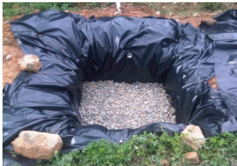
Fotografía 5. Colocación de la grava triturada en el fondo de las piscinas experimentales
