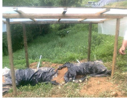
Fotografía 8. Colocación de cubierta de plástico para la protección de las piscinas.
