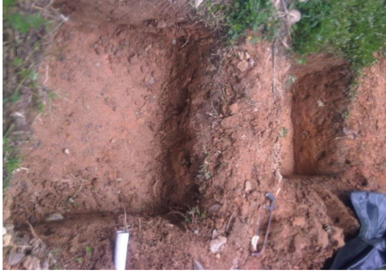
Fotografía 2. Piscinas experimentales construidas
