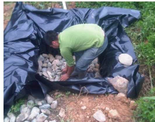
Fotografía 4. Colocación de los materiales en la piscina
