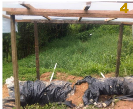
Instalación de la tubería para desagüe de lixiviados.
