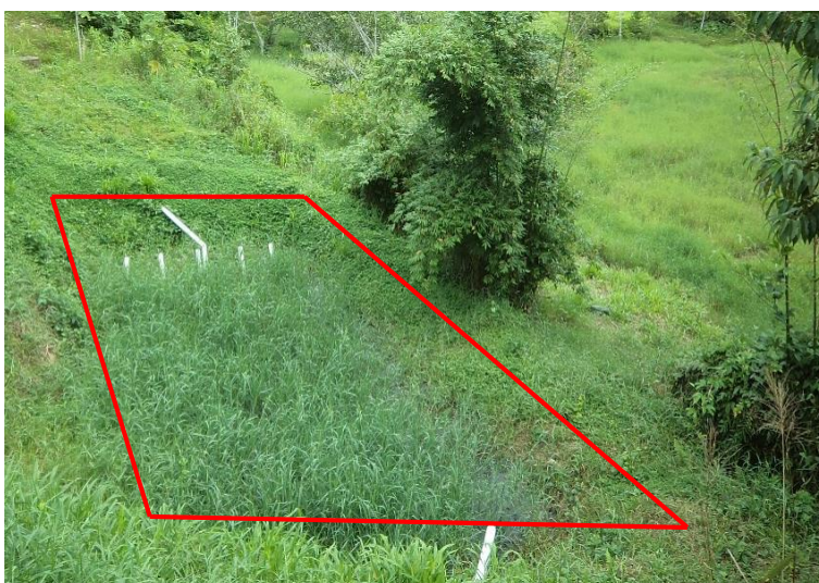
Fotografía 18. Laguna de tratamiento de los lixiviados
