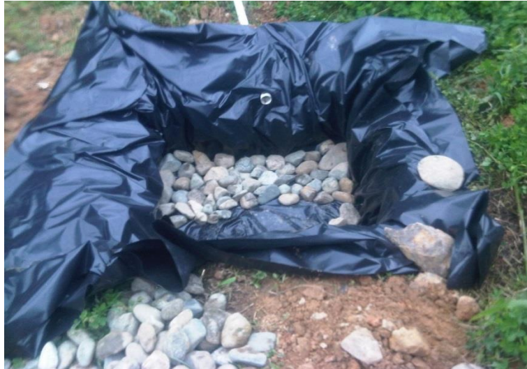
Fotografía 4. Colocación de piedra mediana sobre la base de la piscina.
