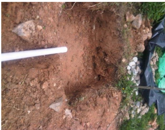
Fotografía 3. Colocación de la tubería para el desagüe de los lixiviados
