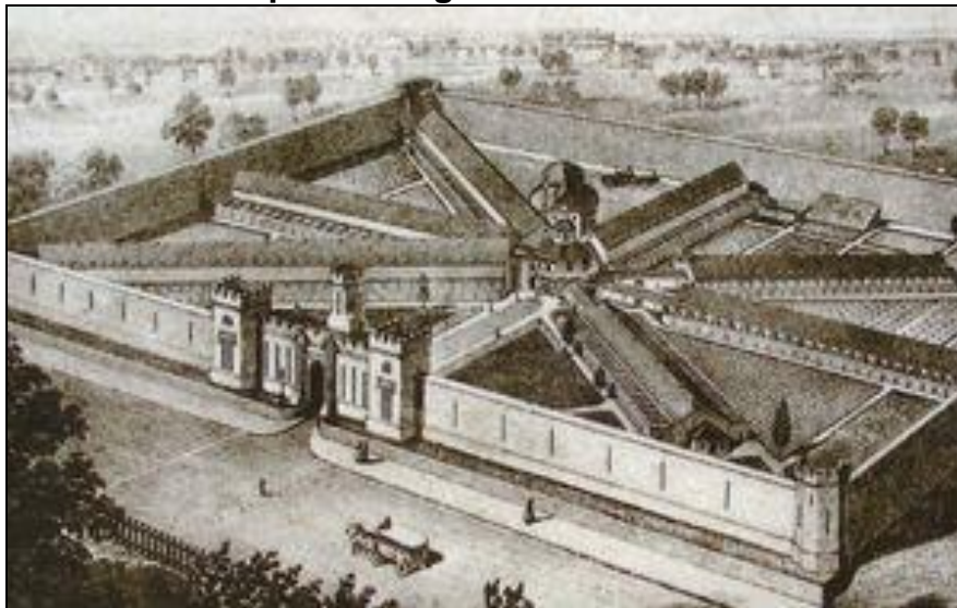
Imagen 4: Penitenciaría de Eastern State de Filadelfia, EUA, diseñada por el arquitecto inglés Jhon Haviland
