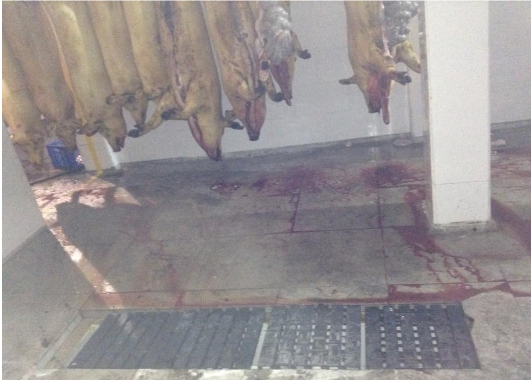
Descarga de efluentes a canaleta
