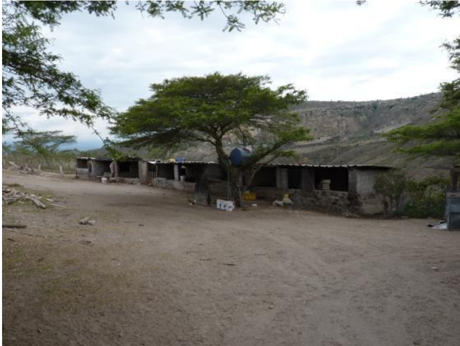
FOTO 9. Instalaciones para cerdos
