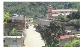
Vía principal de la parroquia
