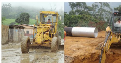
Obras en ejecución por el GAD
