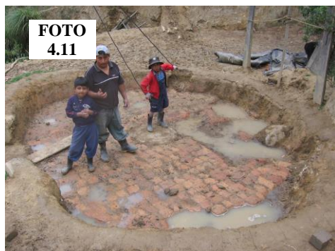
Foto 4.11 y foto4. 12: Hueco practicado en el piso junto a la fábrica utilizado para realizar el mezclado de dos Suelos.
