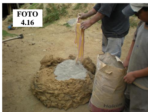
Foto 4.16: Momento en el que se adiciona el cemento al barro Foto 4.17: Se muestran balanza y balde, se adiciona 1 litro de agua por kg. de cemento para necesario mantener la trabajabilidad del barro.
