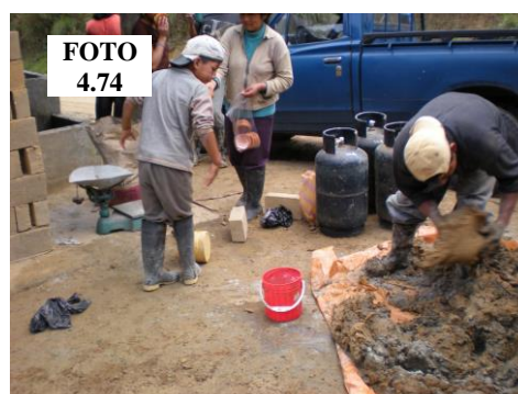
Foto 4.16: Momento en el que se adiciona el cemento al barro Foto 4.17: Se muestran balanza y balde, se adiciona 1 litro de agua por kg. de cemento para necesario mantener la trabajabilidad del barro.
