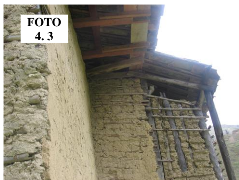
Foto 4.3: Vivienda con pared deteriorada.
