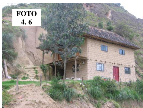
Foto 4.6: Vista frontal vivienda de adobe.
