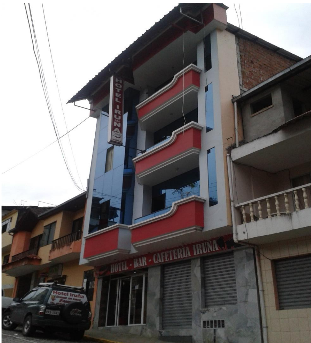
Gráfico N° 16. Infraestructura del Hotel Iruña
