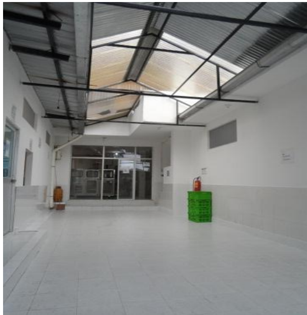
Fotografía 3 Infraestructura de la empresa.
