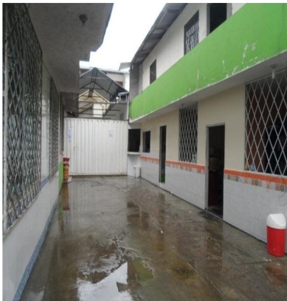
Fotografía 4. Zona de despacho.
