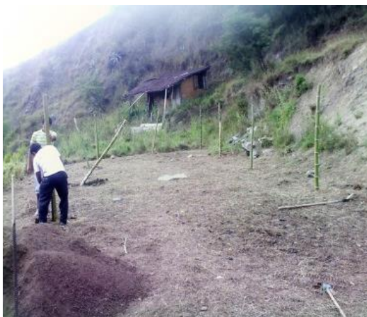
Fig. 5. Construcción de la estructura del vivero de café, Loja 2013.
