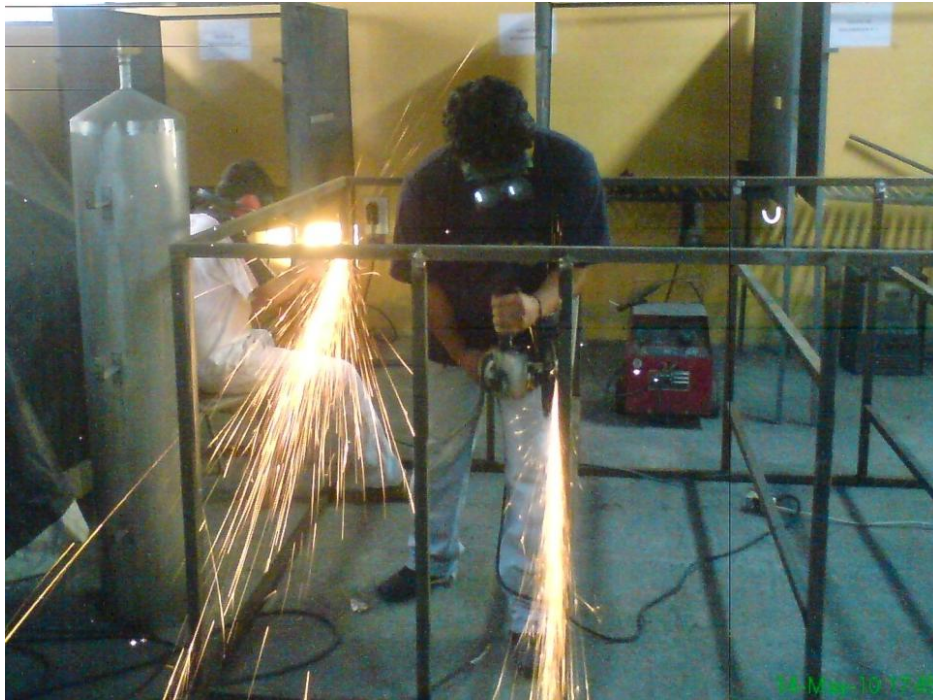
Fotografía 1. Construcción de la estructura metálica.
