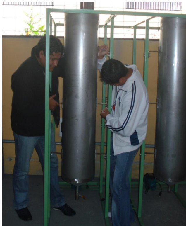
Fotografía 2. Montaje de los tanques.
