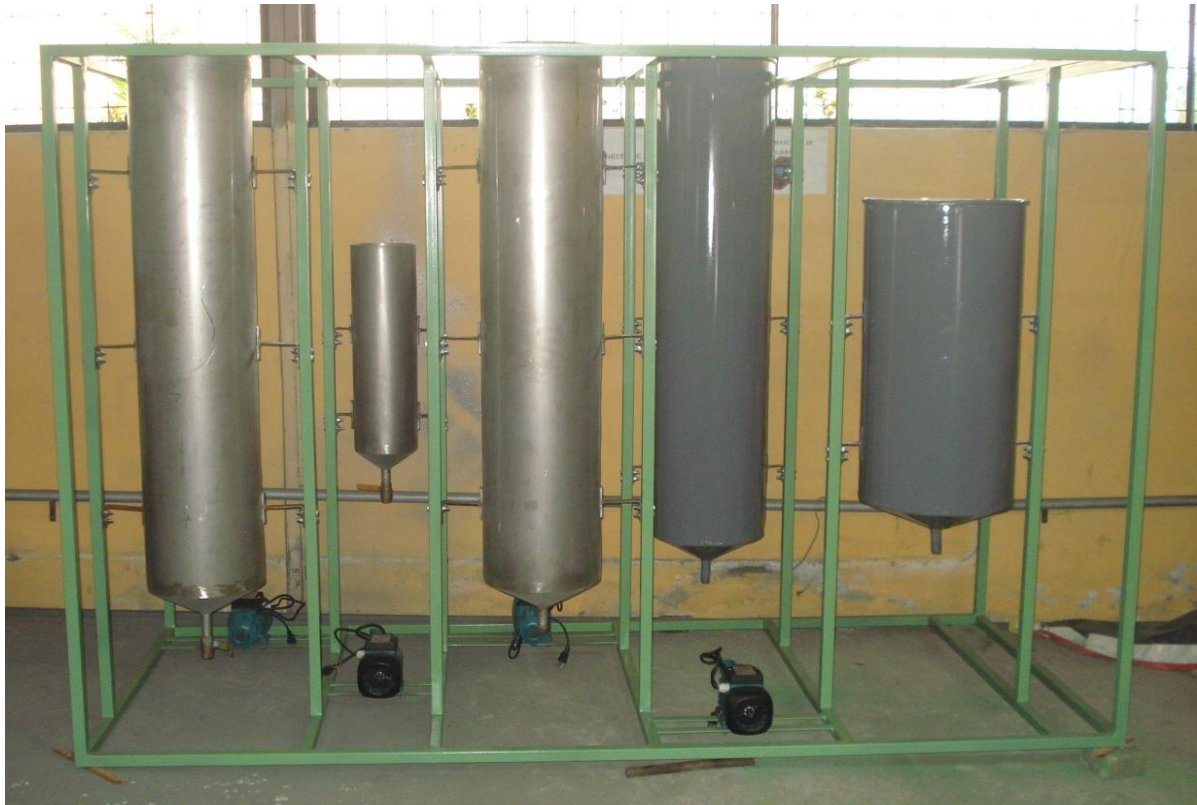
Fotografía 3. Montaje de tanques y bombas en la estructura.
